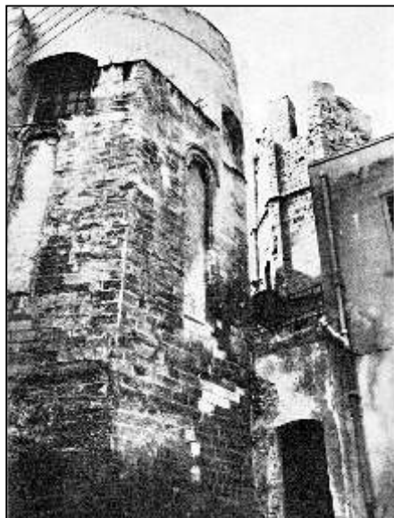
Abside esterno della Chiesa di San Domenico
