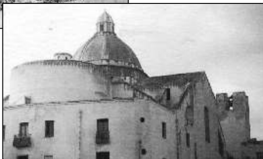
Esterno Chiesa di S. Pietro dopo il restauro
