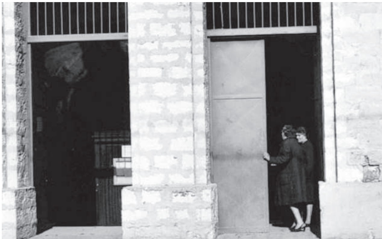
La foto ha fissato la firma dell'alluvione. Il segnale sulla parete esterna sta a indicare dove è arrivata l'acqua; quello sulla porta, più evidente, ci dice a quale altezza l'acqua è rimasta a lungo prima di cominciare a defluire
