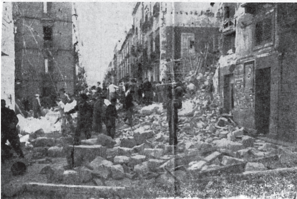
L'edificio di Corso Vittorio subito dopo il pauroso crollo.
