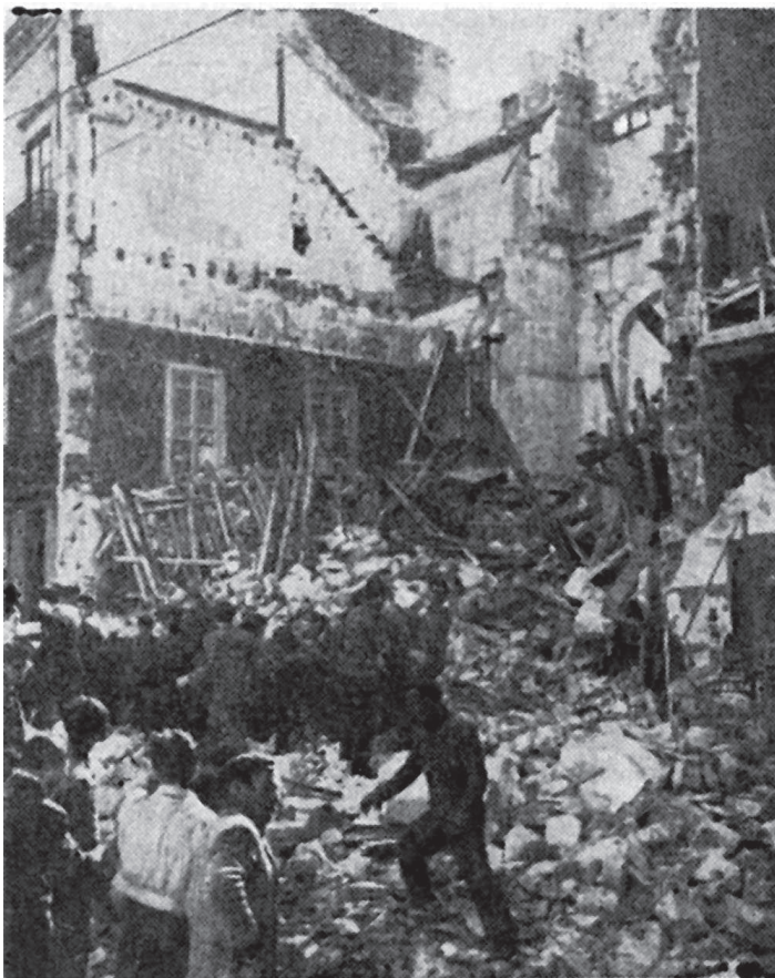
Particolare del palazzo crollato: dalle macerie sono stati estratti i cadaveri di un uomo, una donna e due bambini.
