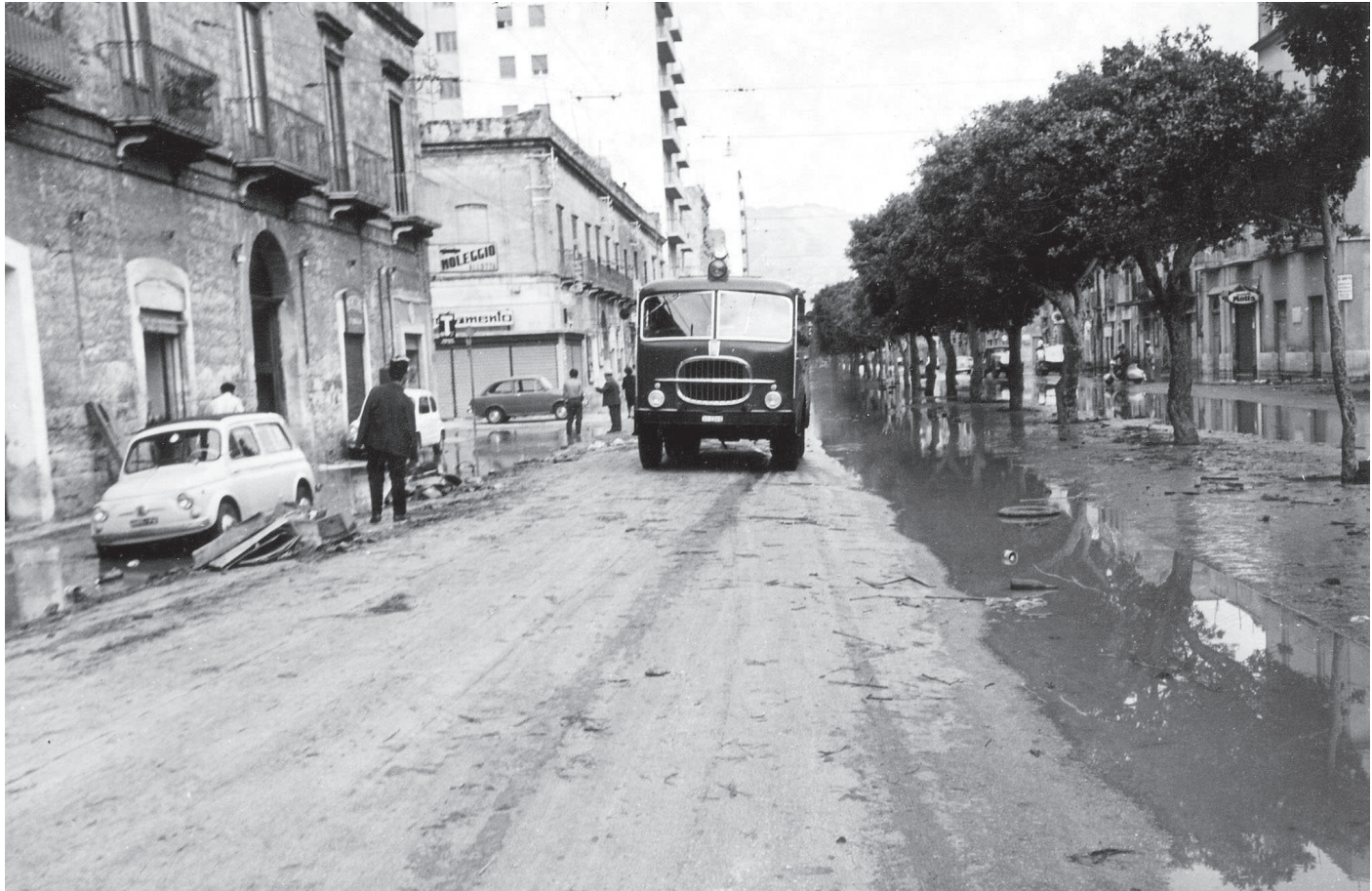
La tremenda alluvione del novembre 1976 ha messo ancora una volta Trapani in ginocchio. Via G. B. Fardella è sotto il fango e i Vigili del Fuoco sono all'opera all'altezza di Via Nicolò Riccio
