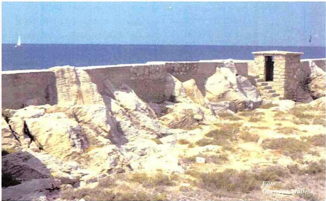
Muro di cinta esterno con postazione
