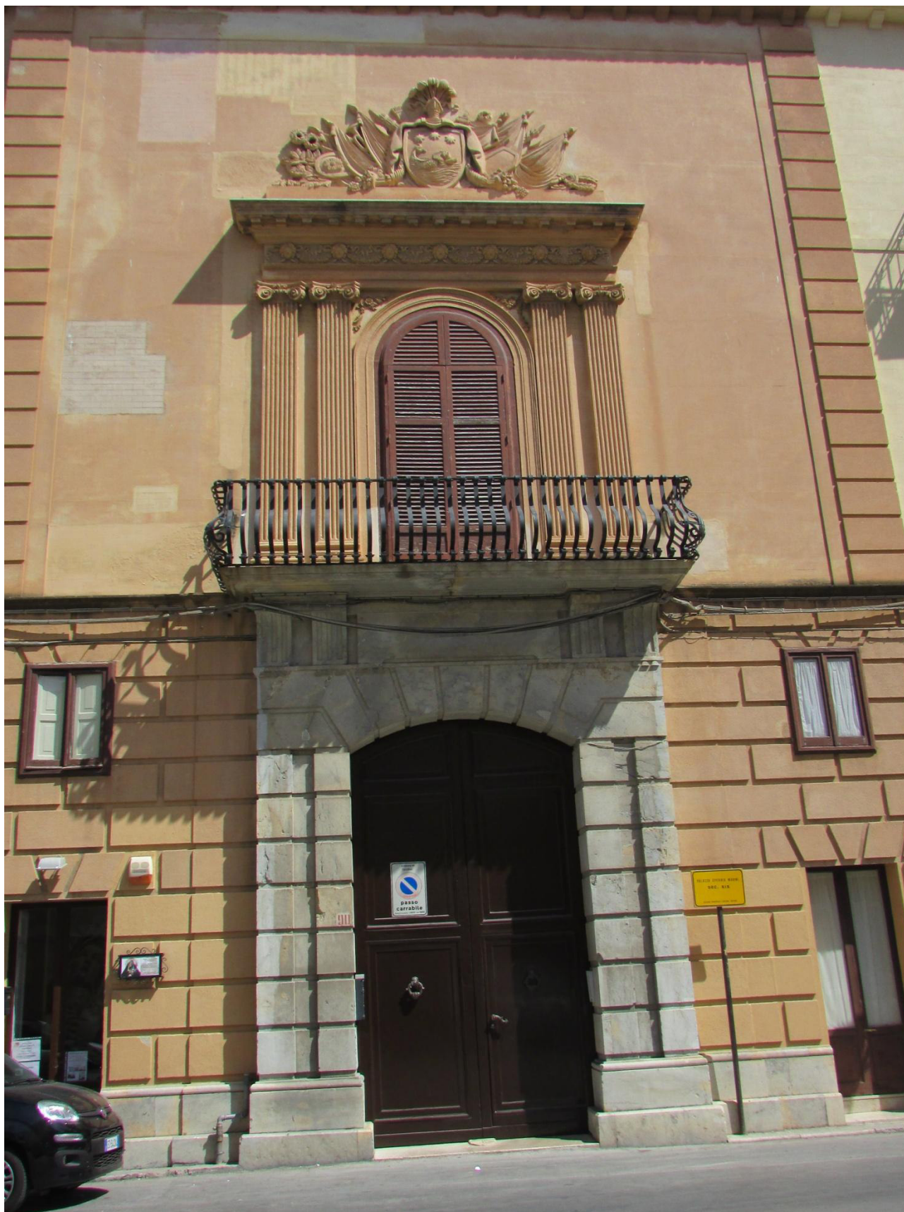
Palazzo della Famiglia Marini (in ultimo di Epifanio Marini) con particolare del fregio. Posteriormente l'edificio è addossato alle mura di tramontana e gode di una mirabile vista sul Bastione Conca (Foto L.S.)
