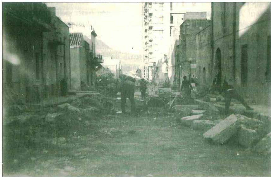
Sistemazione della via Speranza e «Grattacielo» ancora in costruzione nei primi anni '60
