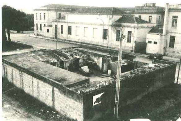
Recinto costruito abusivamente nei pressi della Scuola elementare e del Poliambulatorio, e rimasto ad eternare il provvisorio
