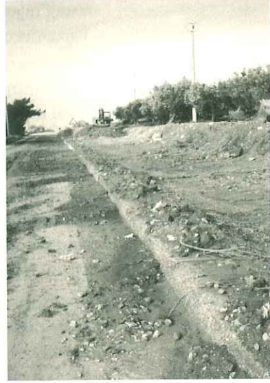
Via C/etrano «Lavori in corso»
