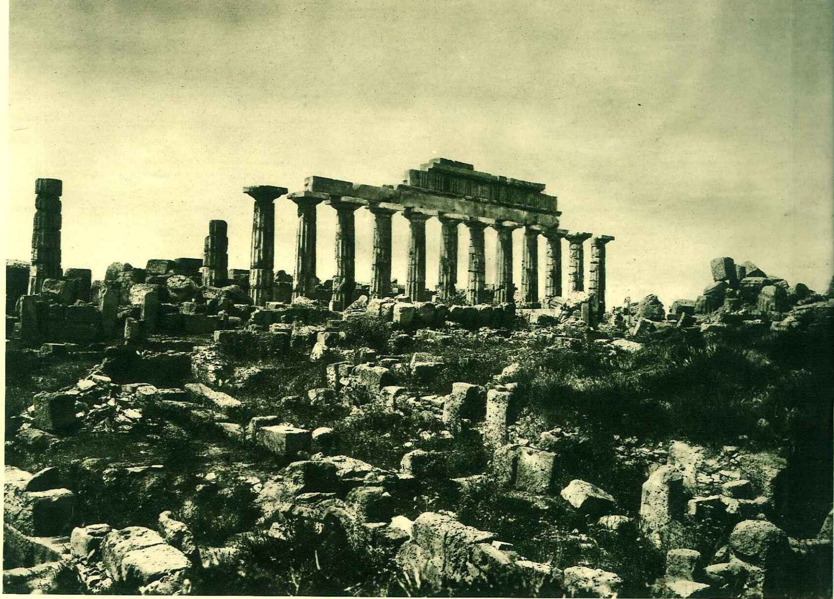
ACROPOLI DI SELINUNTE - RICOSTRUZIONE PARZIALE DEL COLONNATO DEL TEMPIO
