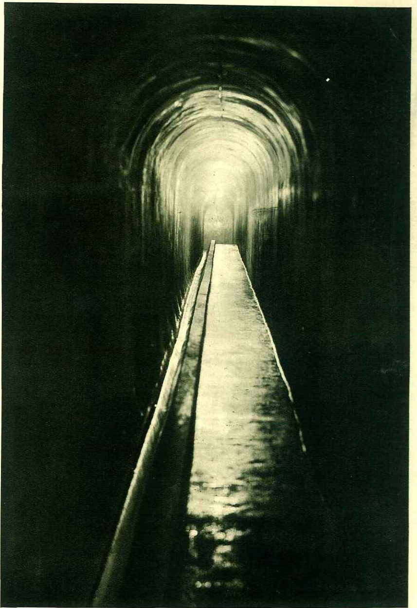
INTERNO DI UNA GALLERIA DI EMUNGIMENTO
