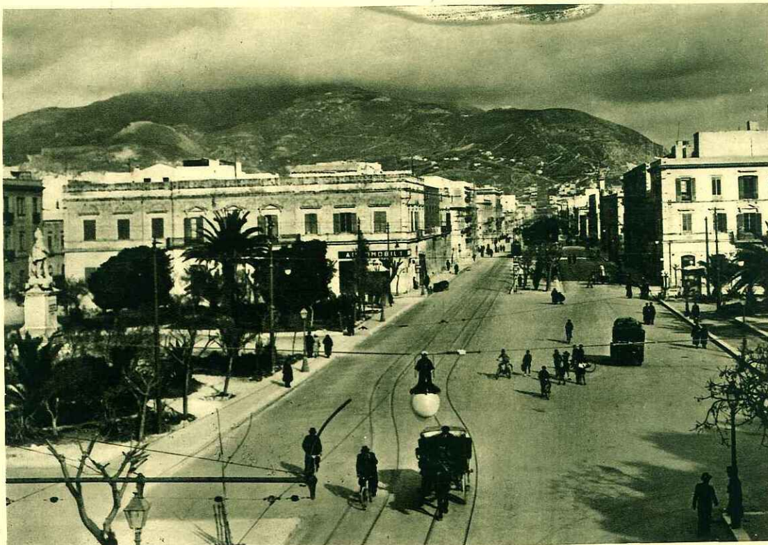
VIA G. B. FARDELLA - SISTEMAZIONE DELLE AIUOLE
