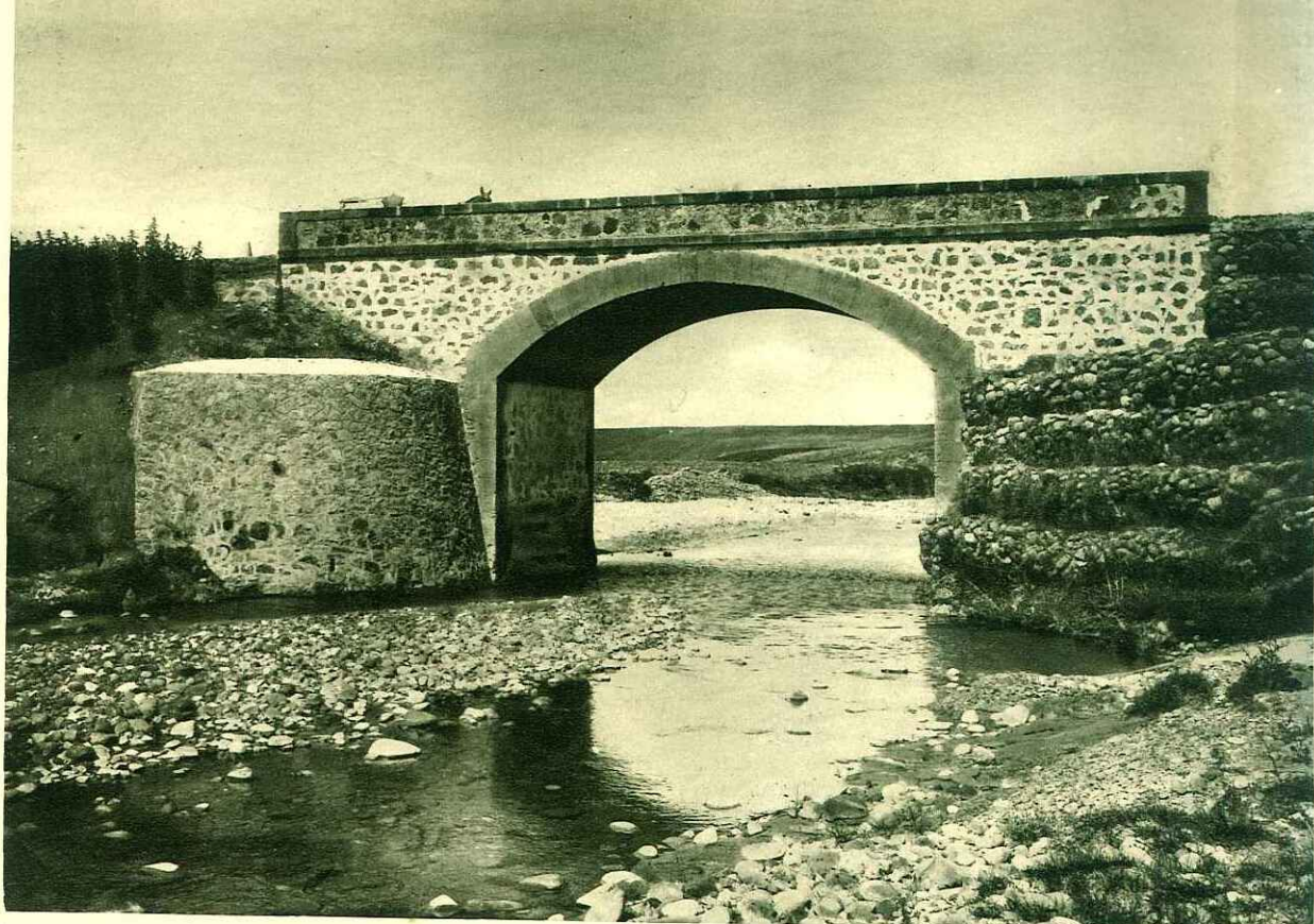
STRADA DI CASTELVETRANO - PONTE SUL TORRENTE CUDDIA
