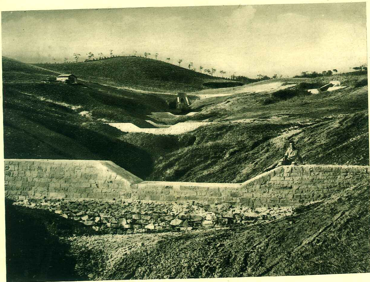
STRADA DI CAMPOREALE - IM- BRIGLIAMENTO DEL TORRENTE FERRICINO
