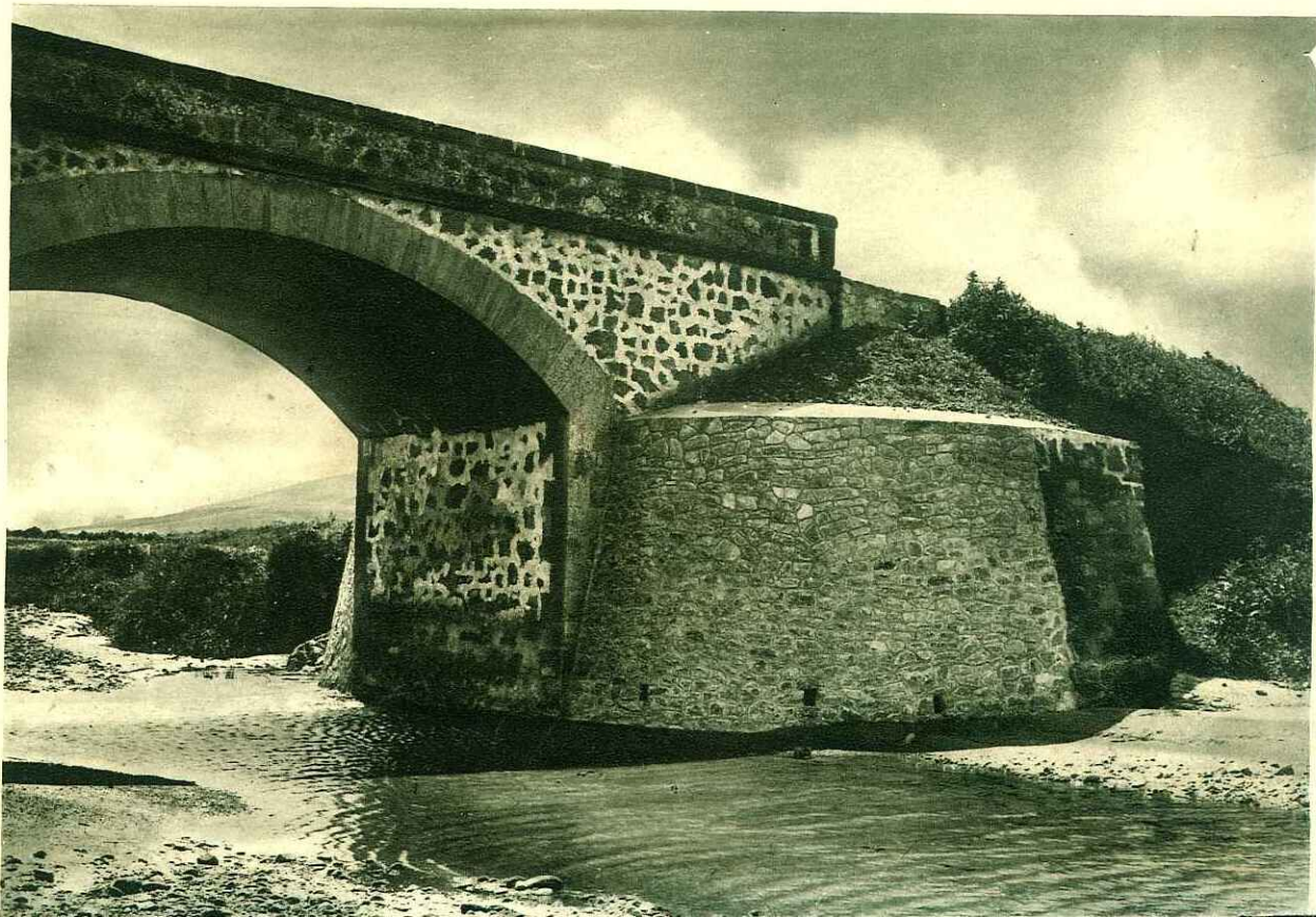
STRADA DI CASTELVETRANO - PONTE SUL TORRENTE CUDDIA
