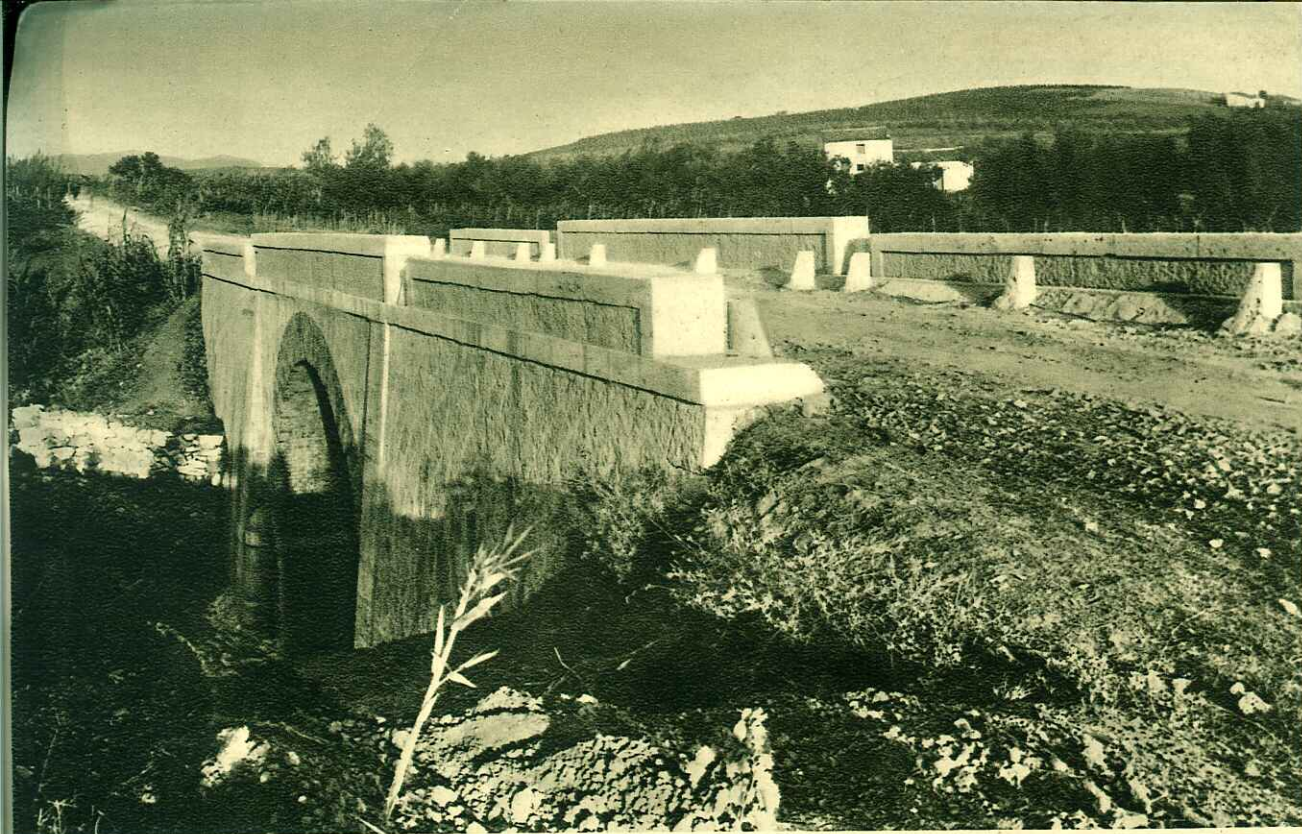
PONTE BIANCHINO SULLA STRADA DI PASSOFONDO
