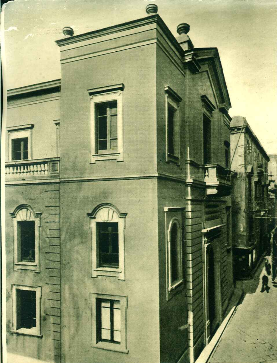
LABORATORIO PROVINCIALE D'IGIENE E PROFILASSI PROSPETTO ESTERNO DELL'EDIFICIO
