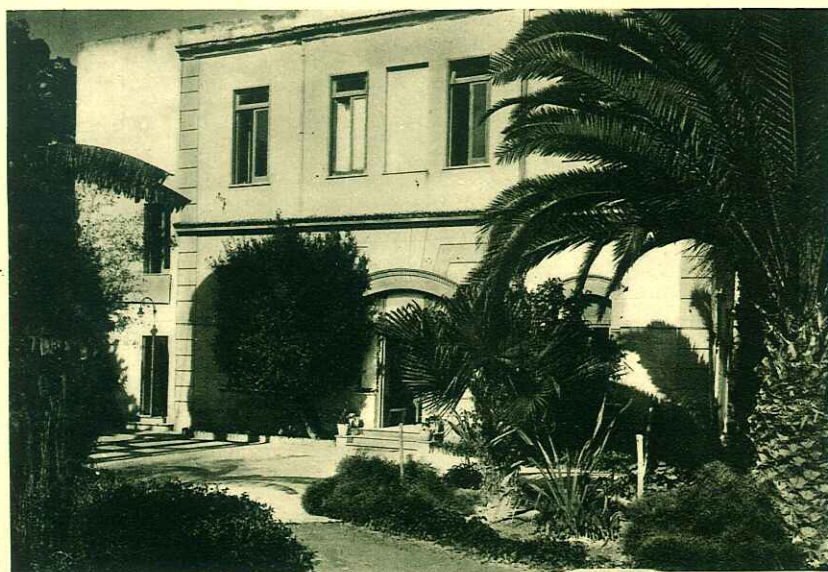
PARTICOLARE DEL REPARTO DI DEGENZA PNX.
