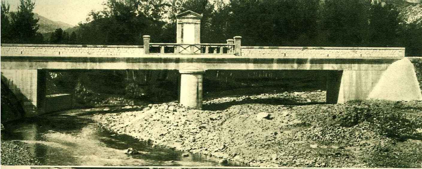
STRADA DI ALLAC- CIAMENTO DELLA STATALE 113 ALLA FRAZIONE BRUCA: PRIMO TRONCO AL TEMPIO DI SEGESTA PONTE IN CEMENTO ARMATO SUL FIUME FREDDO
