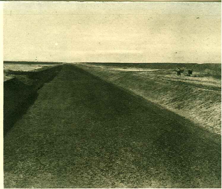
ARGINE DEL TORRENTE BIRGI VISTO DALLA PASSERELLA SULLA STRADA TRAPANI-MARSALA
