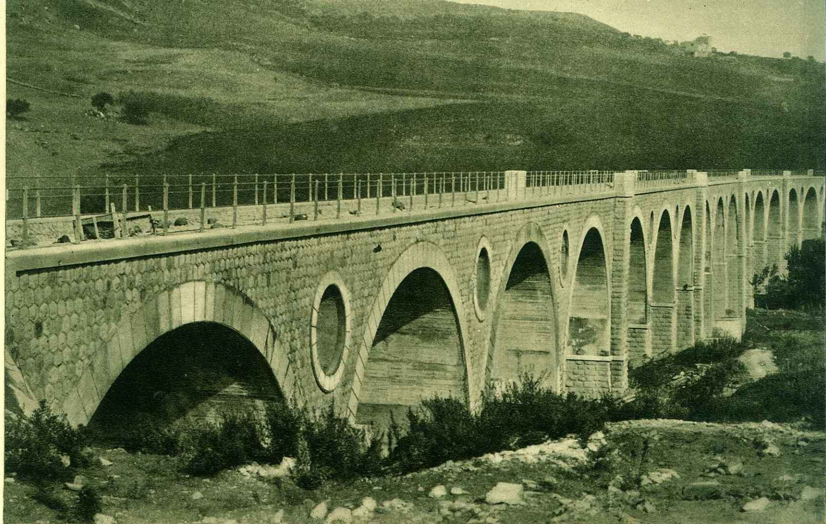
LINEA SEGESTA-TRAPANI: VIADOTTO A 16 LUCI DA M. 15 CIASCUNA SUL FIUME KAGGERA
