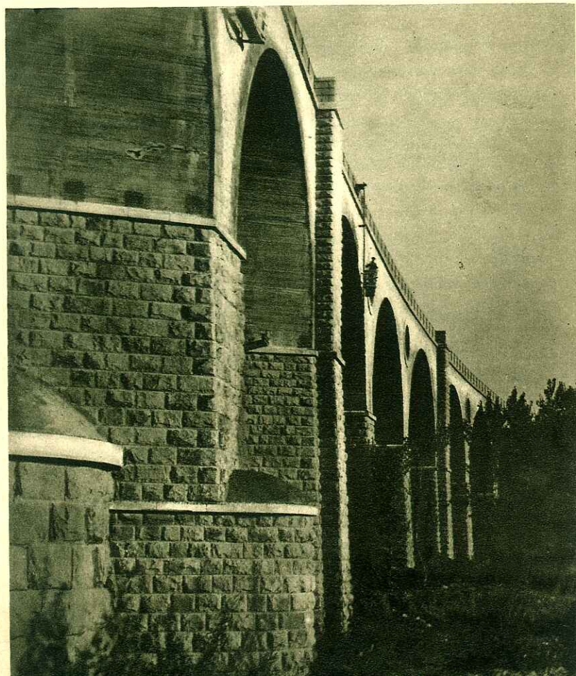
LINEA TRAPANI-ALCAMO: DETTAGLIO DEL GRANDE VIADOTTO SUL KAGGERA.
