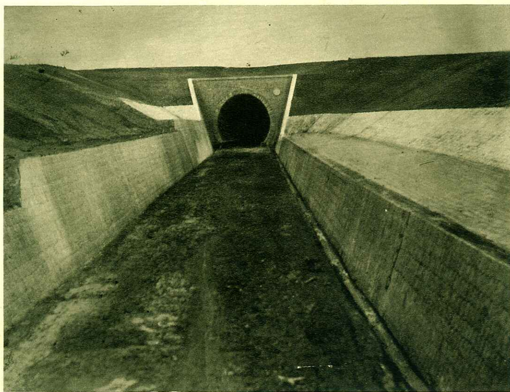
LINEA TRAPANI-ALCAMO : IMBOCCO PALERMO DELLA GALLERIA FULGATORE
