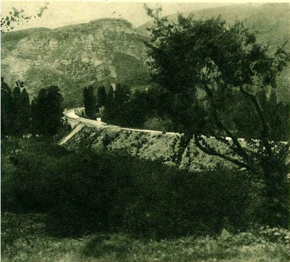
LINEA TRAPANI-ALCAMO : UNA GRANDE CURVA (RILEVATO E VIADOTTO)
