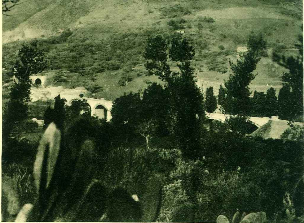
LINEA TRAPANI ALCAMO : VIADOTTO A 11 LUCI DA M. 15 CIASCUNA (2° ATTRAVERSAMENTO FIUME KAGGERA) ED IMBOCCO DELLA GALLERIA DI MONTE BARBARO, SUL CULMINE DEL QUALE TROVASI L'ANFITEATRO DI SEGESTA
