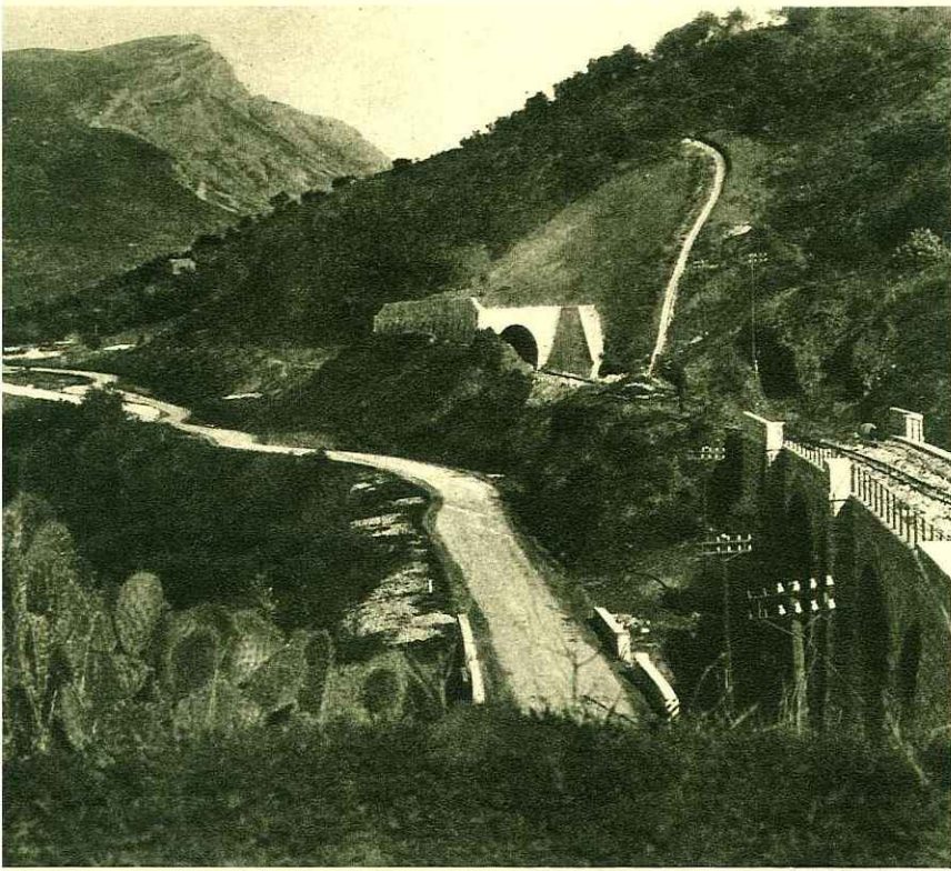
LINEA TRAPANI-ALCAMO: UNA GALLERIA ARTIFICIALE E DEVIAZIONE DELLA STRADA NAZIONALE PALERMO-TRAPANI
