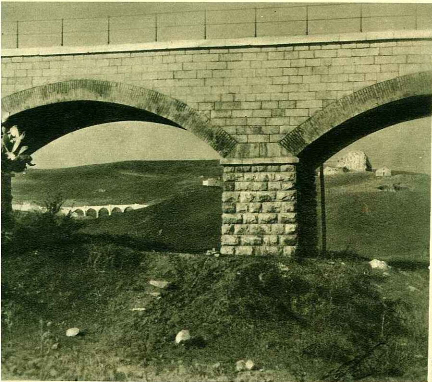
LINEA TRAPANI-ALCAMO: DETTAGLIO DEL VIADOTTO A 4 LUCI IN PROSSIMITÀ DELLA STAZIONE DI KAGGERA
