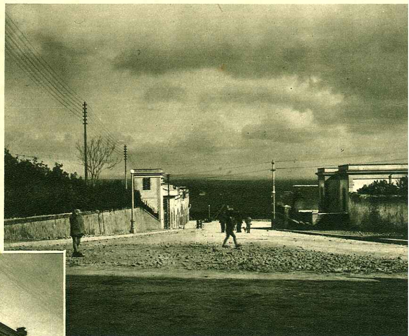
COSTRUZIONE MURO DI SOSTEGNO NEL PARCO DELLA RIMEMBRANZA
