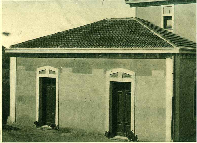
ACQUEDOTTO CIVICO - EDIFICIO DI PRESA A FONTANAROSSA
