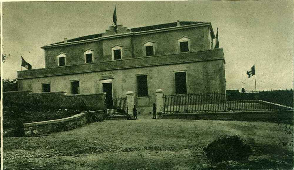
EDIFICIO SCOLASTICO DELLA FRAZIONE BALLATA
