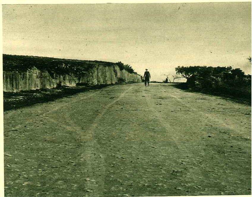
COSTRUZIONE STRADA DI ALLIACCIAMENTO SUTANA
