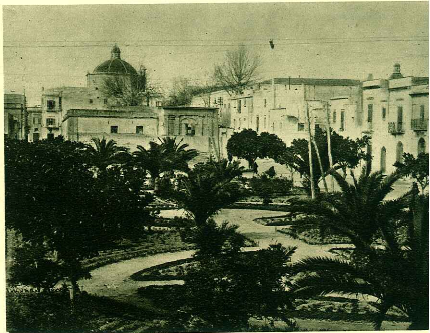
COSTRUZIONE DELLA VILLETTA IN PIAZZA DEL POPOLO
