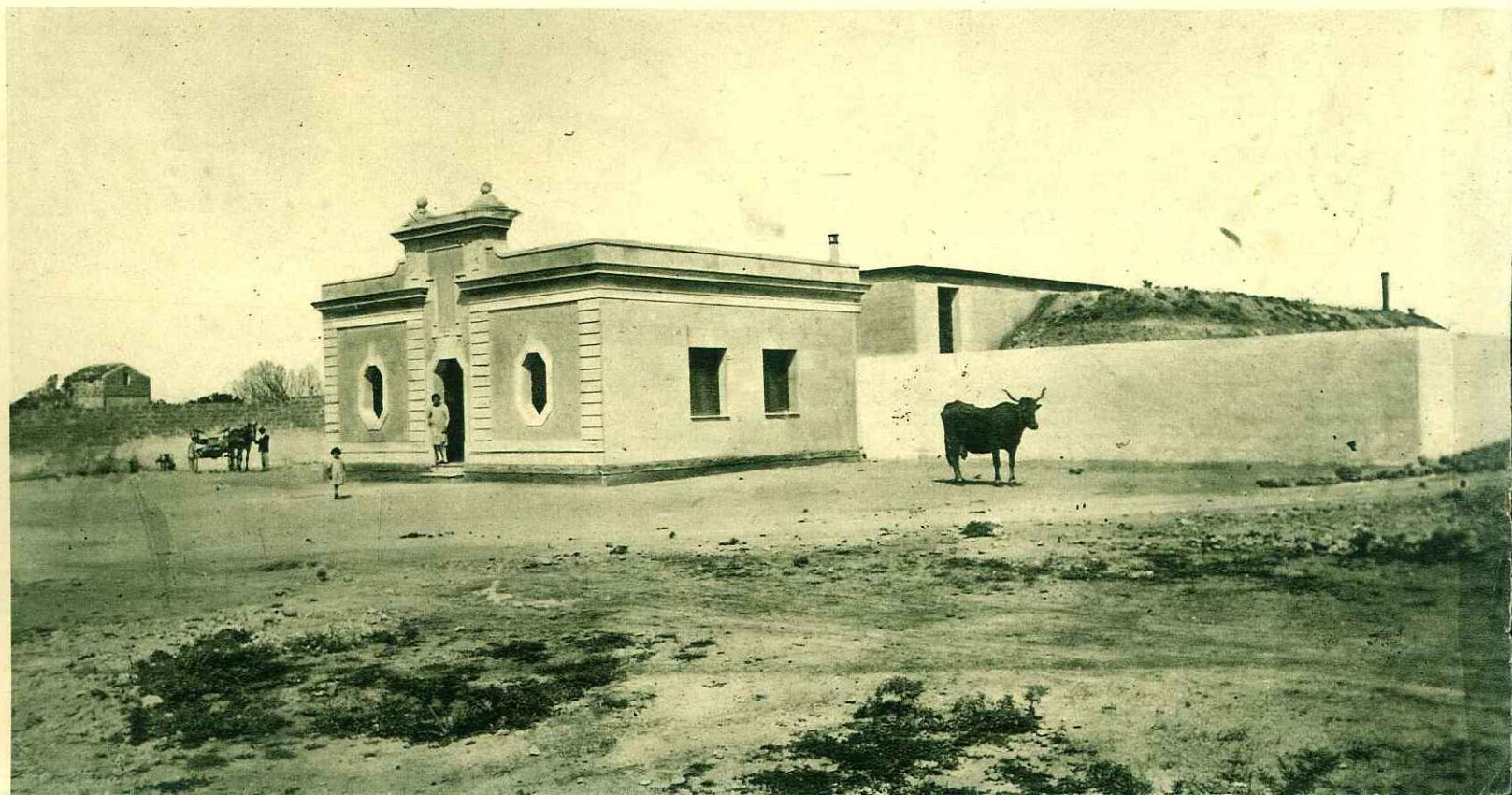
ACQUEDOTTO - SERBATOI E CASA DEL CUSTODE
