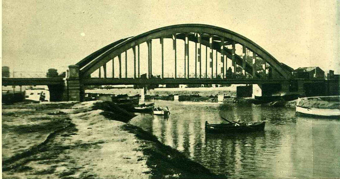
MAZARA DEL VALLO - PONTE IN CEMENTO ARMATO SUL FIUME MAZARO
