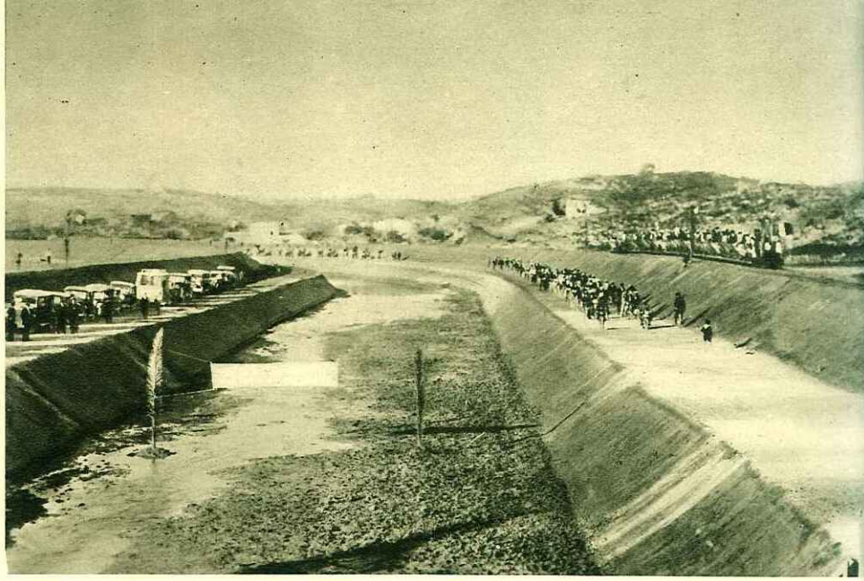
INALVEAZIONE ARGINATA DEL TORRENTE DELIA-ARENA
