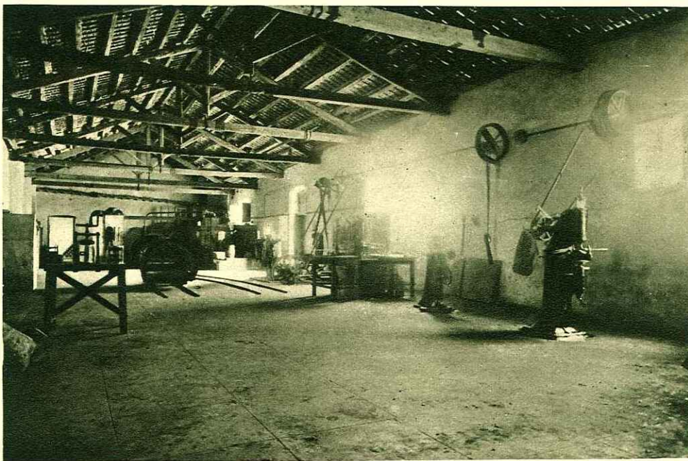
TONNARA DI MARSA ZUAGA REPARTO MACCHINARIO PER LA STERILIZZAZIONE DEL PRODOTTO
