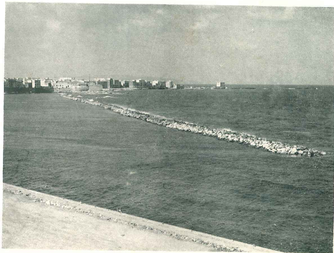
A Tramontana si sono rifatte le mura che erano in più punti cedute e si è provveduto a difendere l'abitato dalla furia del mare con la costruzione di una lunga scogliera.
