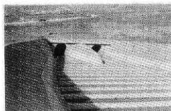
I canali di scarico fanno defluire la sovrabbondanza dell'acqua verso il fiume
