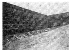
Le potenti fiancate che sostengono l'urto della massa d'acqua: 18 mila metri cubi
