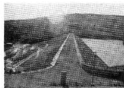
L'irrigazione a pioggia dei fianchi della diga permette la vegetazione erbacea che ha il compito di trattenerne e rassodare la terra
