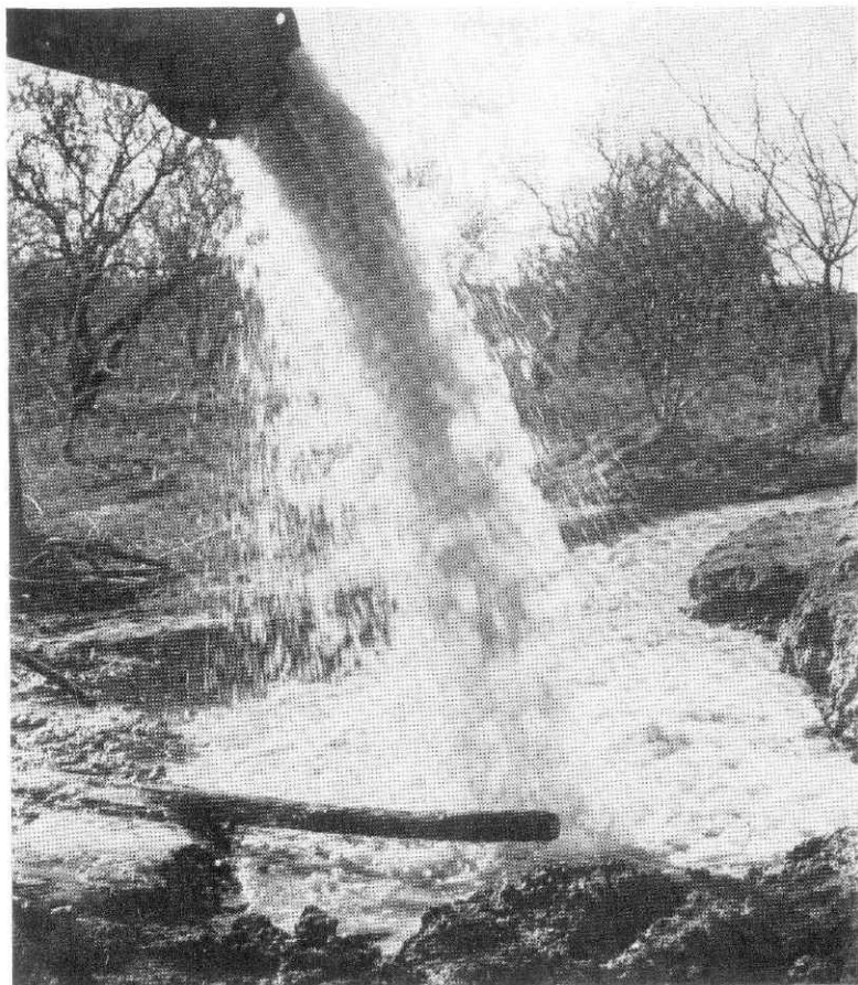
Il potente getto d'acqua ottenuto con una pompa da 75 CV denuncia una portata superiore ai 50 l/s
