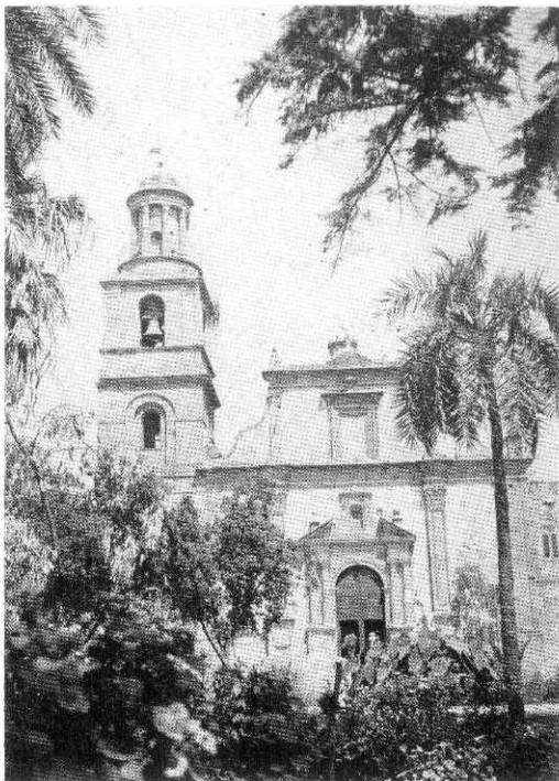
Facciata della Chiesa di S. Giovanni Battista. Sono evidenti i caratteri del tardo Rinascimento e del Barocco. La costruzione della Chiesa iniziata nel 1589 si protrasse fino al 1661. Però nel 1800 subì una radicale modifica e nel 1898, in seguito ad un incendio doloso, venne molto liberamente restaurata. Oltre il Battista del Gagini, la Madonna delle Grazie del Novelli, la Negazione e il Tradimento di Gherardo delle Notti, vi si ammira il coperchio in legno del fonte battesimale eseguito nel 1665 da Mastro Antonino Mangiapane.
