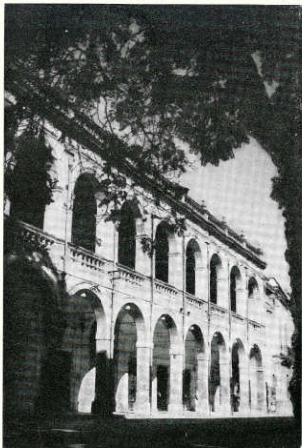
La facciata del Seminario di Mazara (Secolo XVII)
