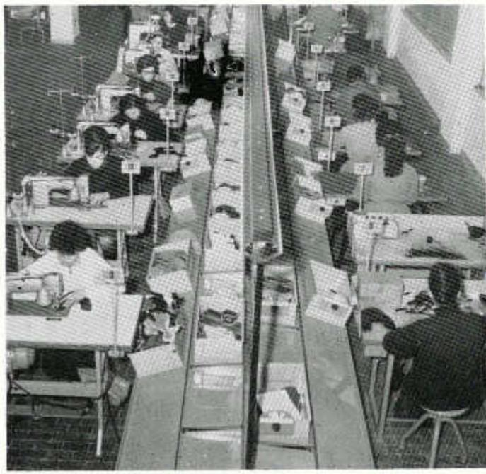
che può montare da 6 a 700 paia al giorno; e poi macchine montapunta, montabuetta, gamborie, ribattrici e il forno automatico a temperatura controllata per asciugare rapidamente le parti incollate.
