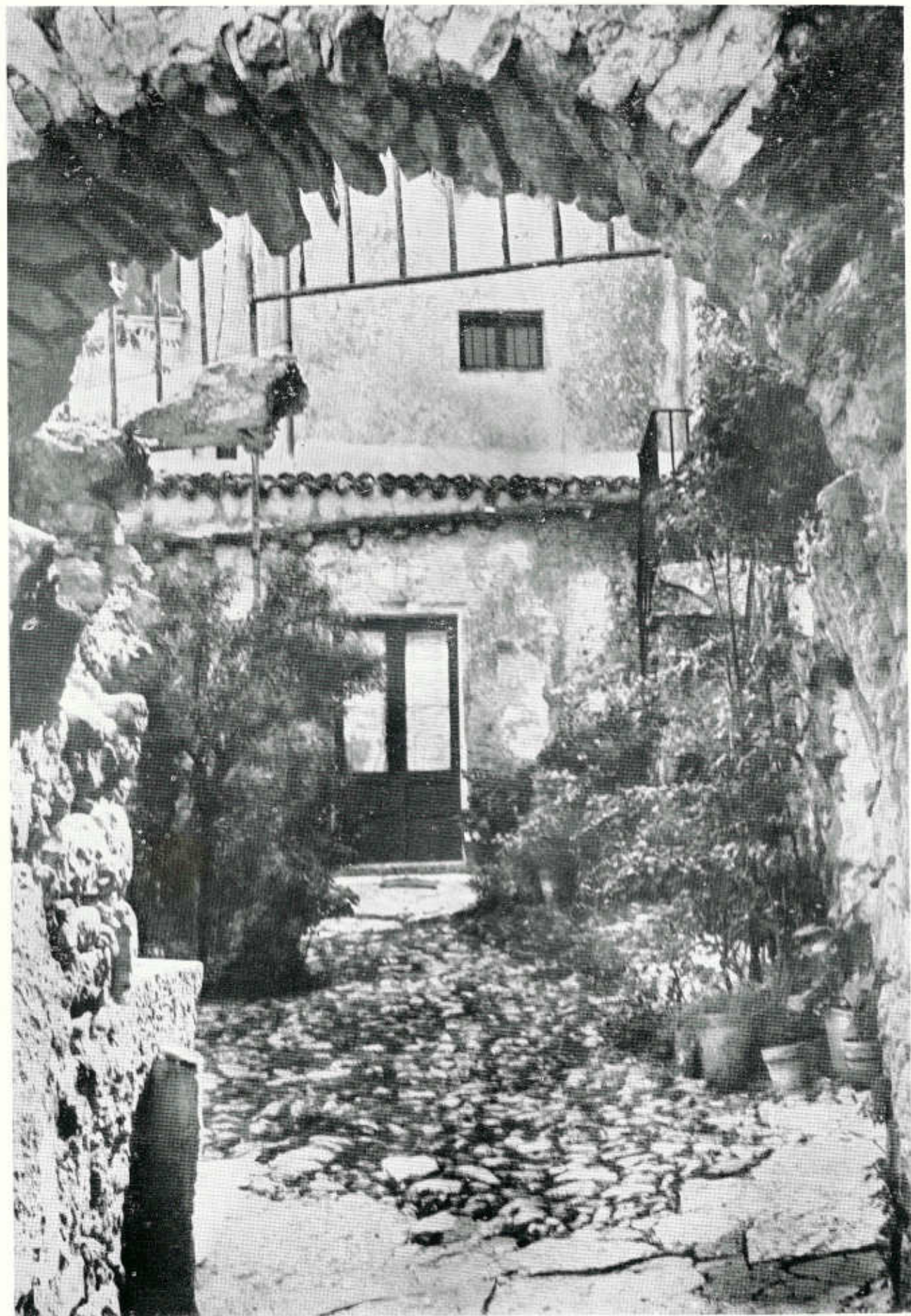
Il cortile di Via Santa Teresa visto dall'ingresso. Da notare l'arco di pietra a « tutto secco » sul quale sovrastava un vano, ora demolito. Anche quest'arco però è in via di disfaccimento
