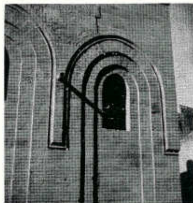
Veduta di un'arcata laterale
