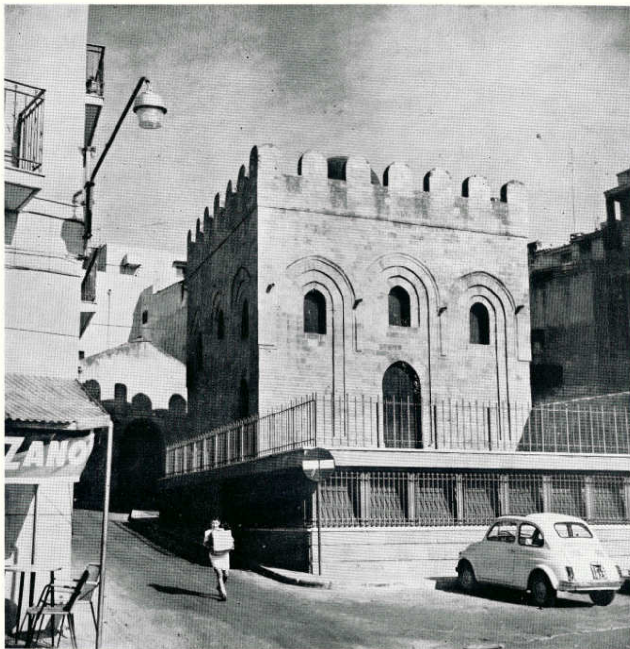
Ecco come si presenta, dopo il restauro, il tempietto visto dal porto. Il paramento murario, trattato a piccoli conci accuratamente squadrate e messi in opera con letti di malta a vista, è un elemento importantissimo dell'architettura arabo-normanna
