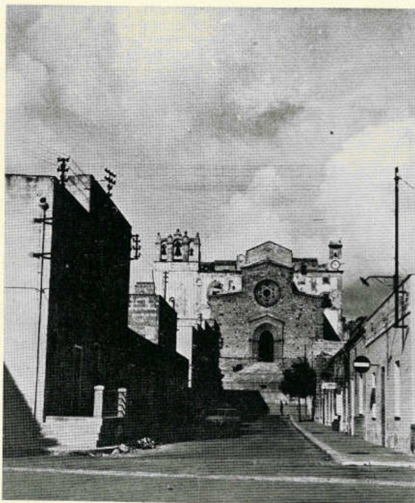
Il prospetto del Santuario di Custonaci, centro spirituale del nuovo «borgo». Attorno ad esso — dal 1791 — si costituì l'attuale centro abitato. Le «Istruzioni» del Natale prevedevano infatti la disponibilità in favore dei «coloni» di aree — da cedere gratuitamente da parte dell'Università — per la costruzione delle abitazioni.
