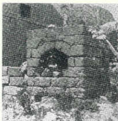
Cofano. Uno dei numerosi forni per la cottura del pane. Talvolta questi forni erano di notevole capacità e consentivano di panificare — in unica cottura — quantità di farina oscillanti dai novanta ai centotrenta chilogrammi
