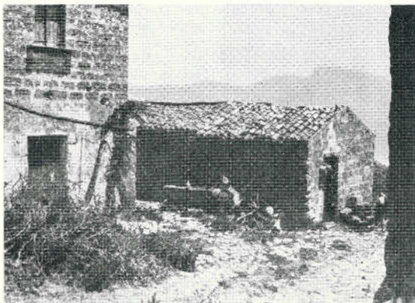
«Masseria» di Cofano. Particolare del «baglio» principale. Da qui si accede ad una serie di «bagli» secondari, tutti quanti fiancheggiati di edifici, adibiti a magazzini o ad abitazione dei lavoranti che spesso vi risiedevano con le loro famiglie.
