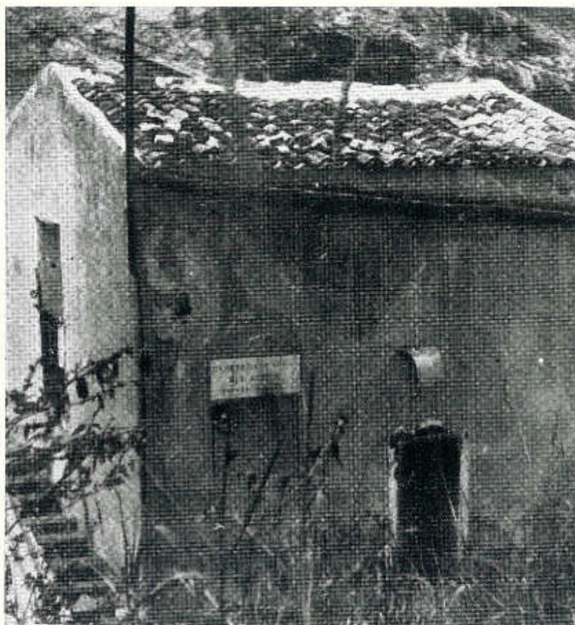
... e quando preparò alcune vasche per bagni alloggiate in un vecchio casamento attiguo al mulino ...
