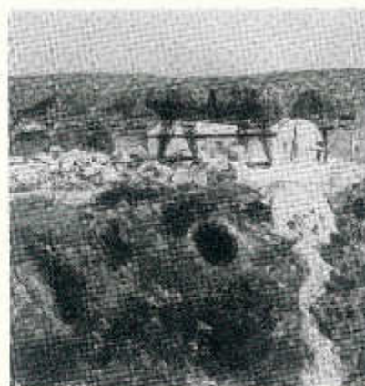
Un'immagine dove tutto è desolazione: stabilimento con il tetto divelto, la enorme gru arrugginita per la lunga stasi e blocchi di marmo accatastati alla rinfusa
