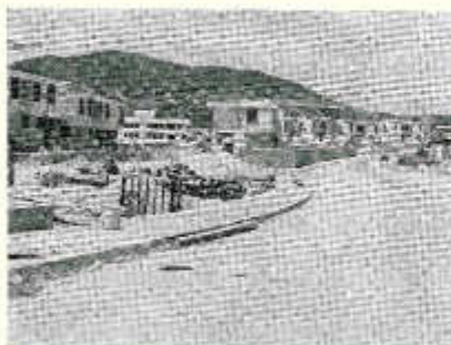
Salemi: Uno dei lotti ultimati a totale carico dello Stato. Le case si presentano abbastanza confortevoli. Ogni abitazione comprende quattro vani e accessori, e in più delle spaziose verande
