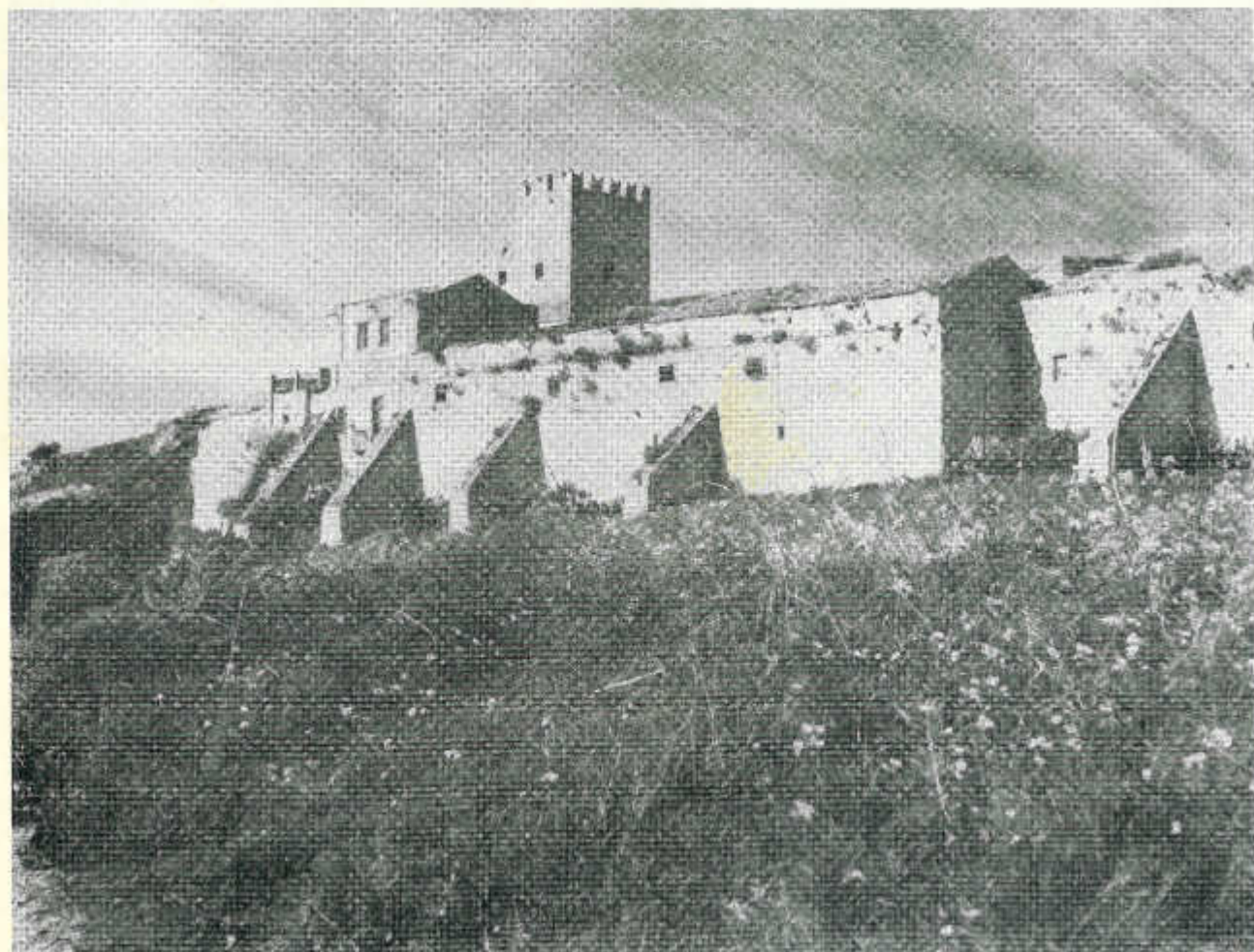
Il castello di Inici. La torre merlata sovrasta il volume dell'edificio, rinforzato e chiaroscurato da robusti contrafforti
