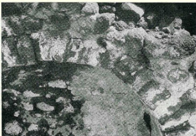
13 - Particolare costruttivo di un dammuso: l'anclo della volta di copertura
