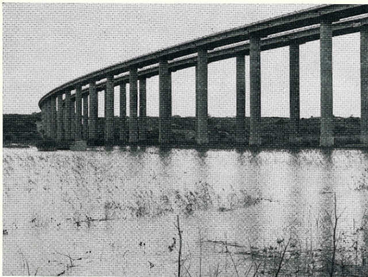
Il viadotto dell'autostrada A 29 Mazara del Vallo-Palermo si specchia nelle acque limacciose del Delia che hanno invaso la campagna mazarese (foto di Francesco Boscarino)
