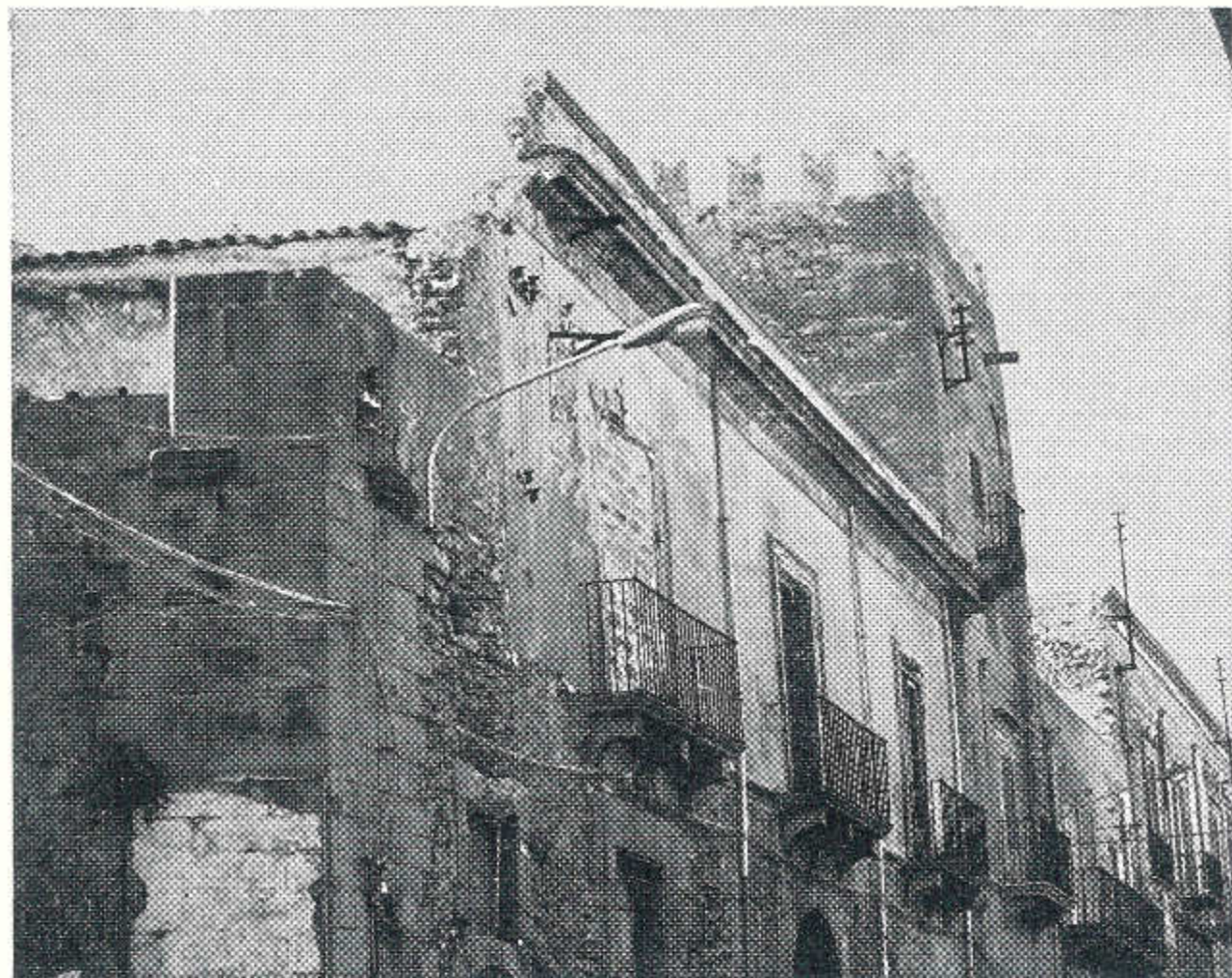
La torre della Vicaria, le carceri vecchie, del XIV secolo, la cui base è stata profondamente deturpata. In primo piano il convento degli Agostiniani costruito nei primi del '600 sui resti della Vicaria. Abbattuto, si è riusciti a salvare parte del portale; sarà presto sede della Biblioteca Comunale e del Museo Selinuntino
