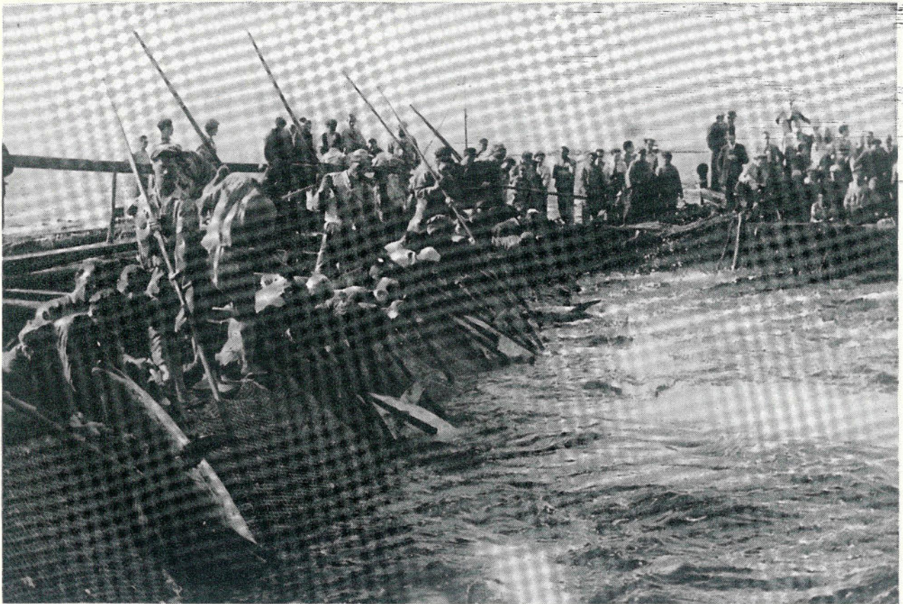
Gli ultimi tonni, che fino all'ultimo momento si dibattono nella «camera della morte» tra la vita e la morte, vengono arpionati e trascinati morenti sul barcaresco
