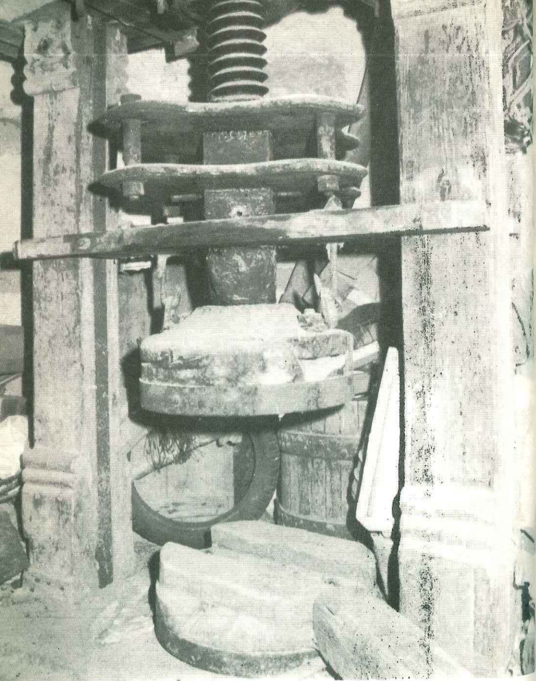
Un torchio ormai abbandonato in un baglio di Martogna
