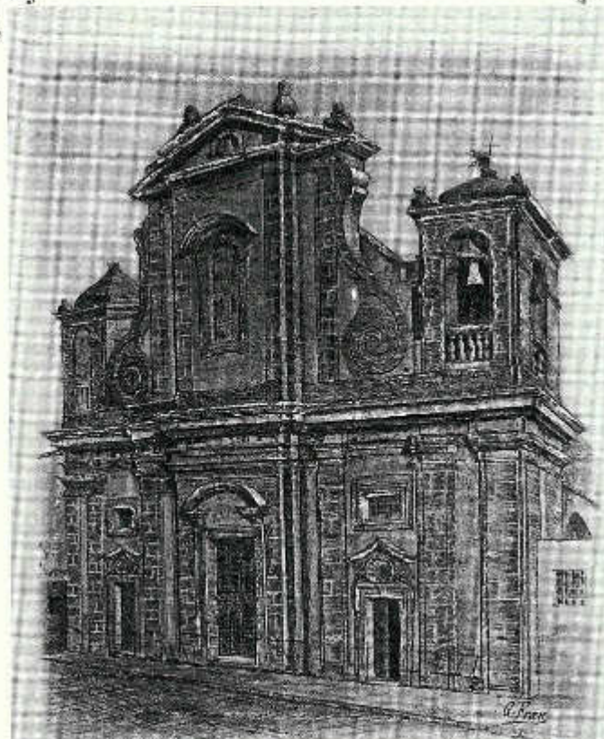
Prospetto della Madre Chiesa Maria S. S. del Soccorso. Castellammare del Golfo
