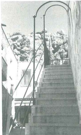
Via S. Catalano: scala esterna in pietra
