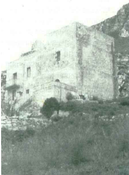
Torre della vecchia tonnara
