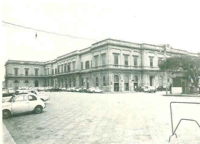
Stazione ferroviaria (panoramica)
