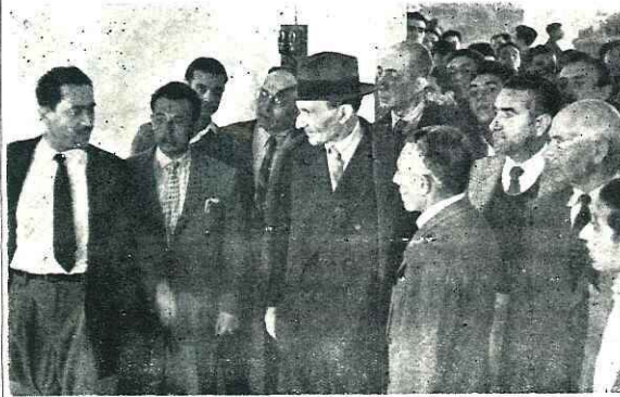
L'on. D'Antoni visita i vari reparti del cantiere Santalucia
