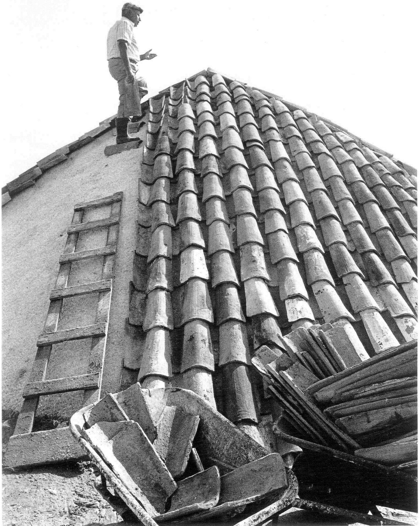
Fig. 11. Mozia. Copertura di un airono con "ciaramire" nella salina Ettore.
