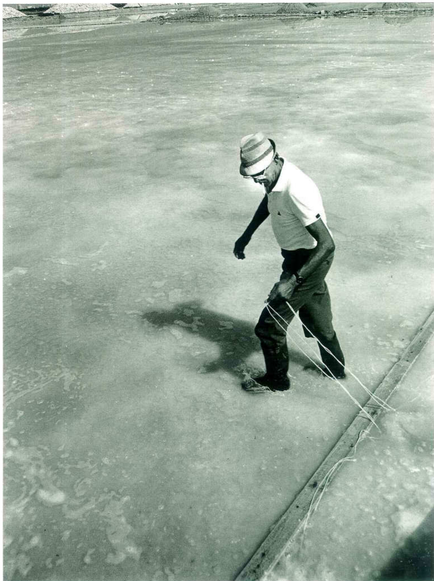
Tav. XXXVI - Trapani, Salina Bella. Pulitura delle incrostazioni.
