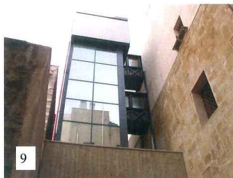
Fig.9 Corpo scale di sicurezza esterno
