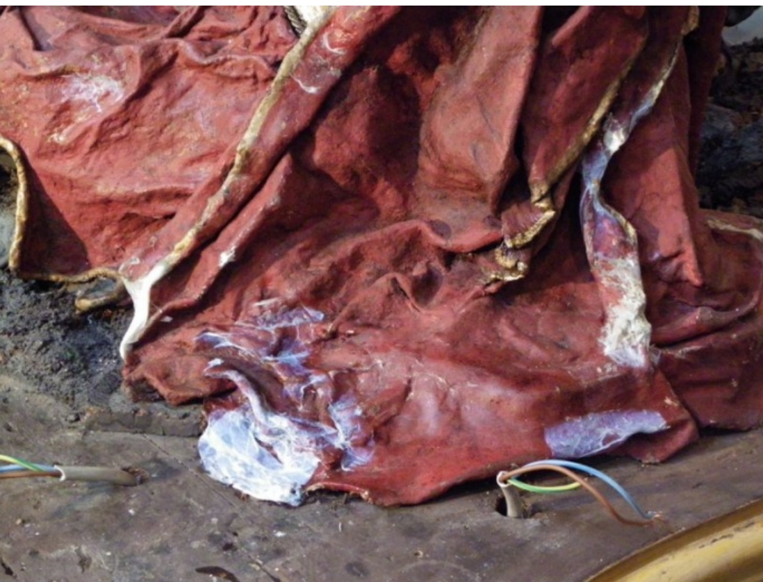
Durante l'intervento di manutenzione
